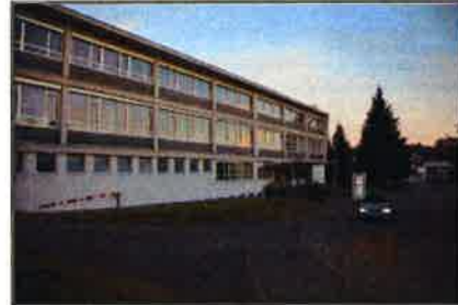
Ansicht aus Nordwest
