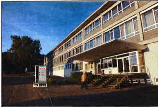
Ansicht aus Südwest
