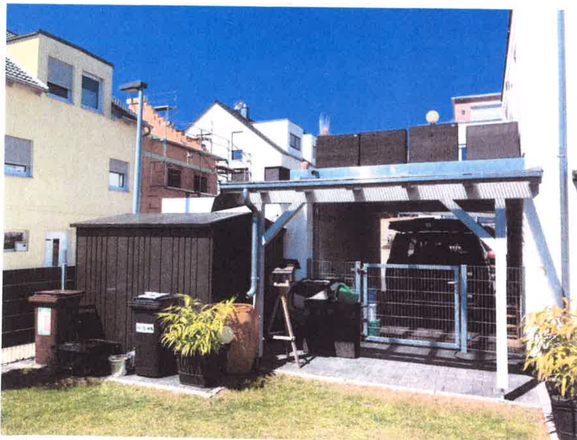
Ansicht Süd: Überdachung hinter Carport und Gartenhütte
