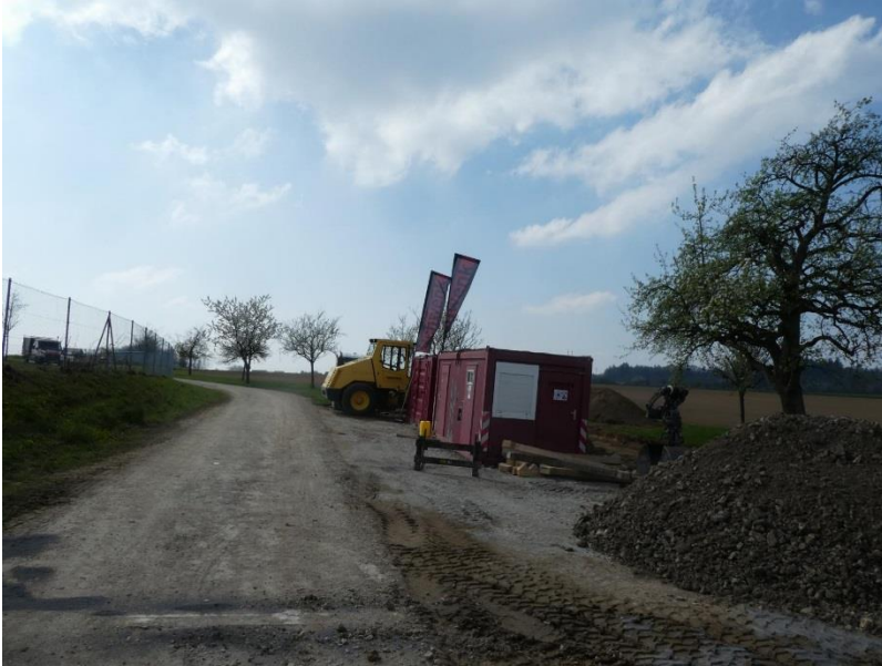
Abbildung 1: Lagerfläche mit Baucontainer und angrenzender Streuobstbestand – April 2019
