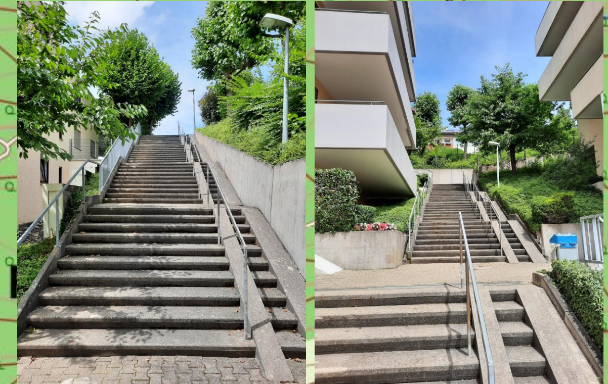
Treppe Breslauer Str. - Risshaldenweg
