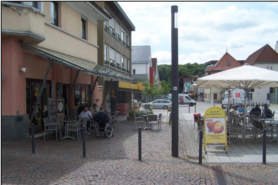
Aktuelle bauliche Situation im Bereich Bäckerei „Zoller“ (Stand Juni 2013)
