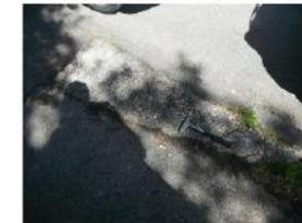
Bild 06 ausbetonierter Zwickel
