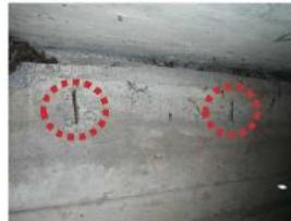
Bild 17 Betonabplatzungen Widerlager
