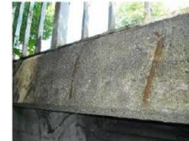
Bild 19 sichtbare Bgelbewehrung Kappe unterstrom
