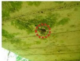
Bild 16 Betonabplatzung Deckerplatte
