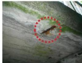
Bild 18 Betonabplatzungen Kappe unterstrom
