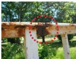
Bild 09 Roststelle an der Bewegungsfuge
