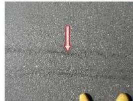
Bild 04 Risse im Asphalt
