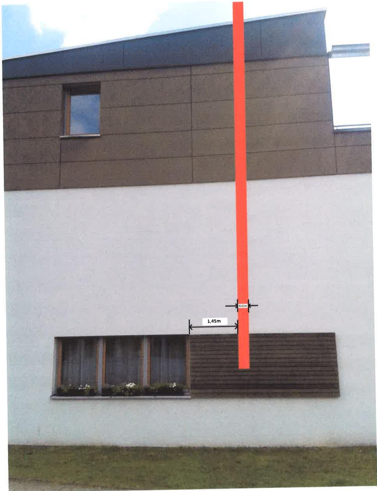
Die Abbildung zeigt die Position des Außenkamins an der Hausfassade
