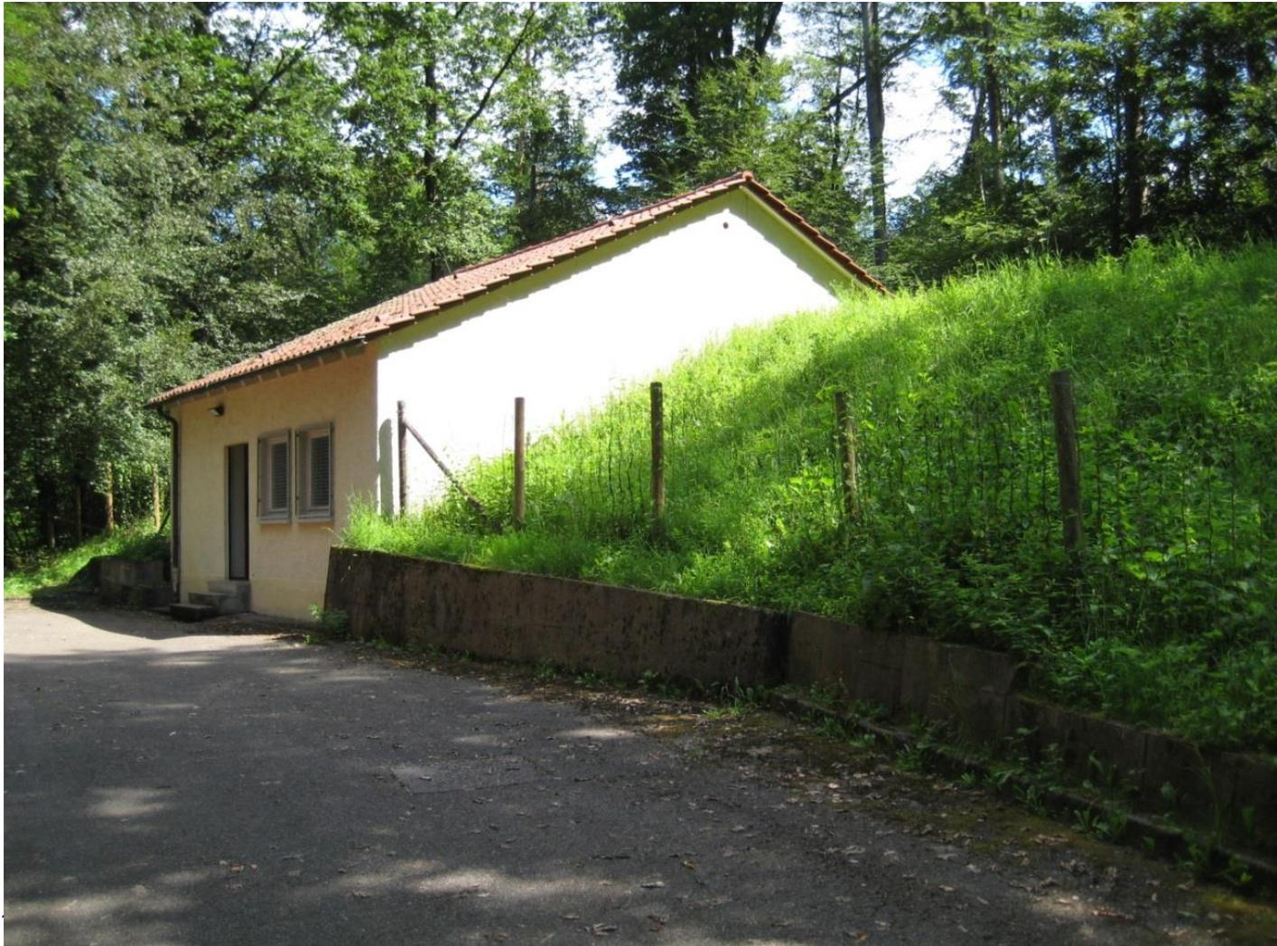
An der Außenfassade und im Bauwerk waren keine Schäden erkennbar. Nach Angaben des Betriebspersonals ist auch die Wasserkammer mangelfrei. Die technische Ausrüstung in Stahl verzinkt mit Korrosionsschutzanstrich ist nur geringfügig korrodiert. Ein grundlegender Instandsetzungsbedarf ist jedoch noch nicht gegeben.
